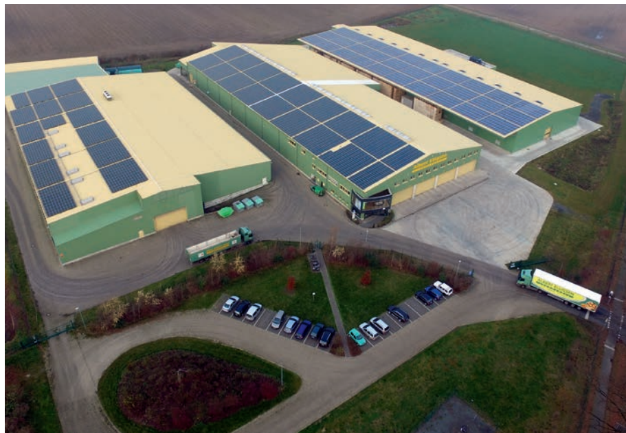
Selbst erzeugter Solarstrom lässt sich gut in das betriebliche Energiemanagement integrieren (Foto: Albert Elligsen Landhandel GmbH)
