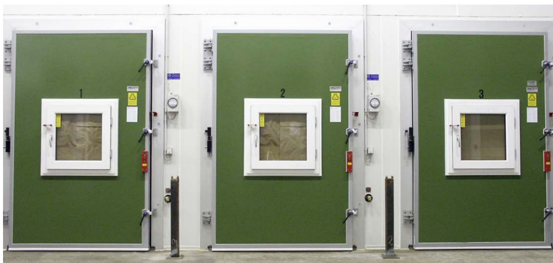
Moderne klimagesteuerte Lagerräume bilden die Grundlage zur Durchführung von Versuchen mit Keimhemmungsmitteln. (Fotos: VSD)
